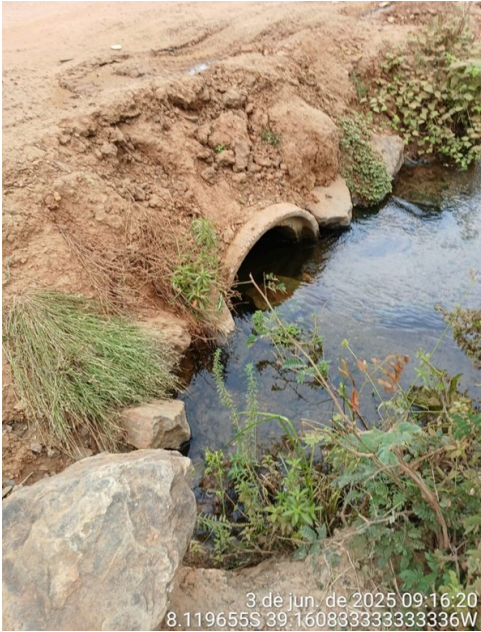
Figura 12 – km 5,5 – LE - 2 tubos Ø 0,60 m
