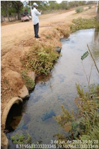
Figura 11 – km 5,5 – LD - 2 tubos Ø 0,60 m
